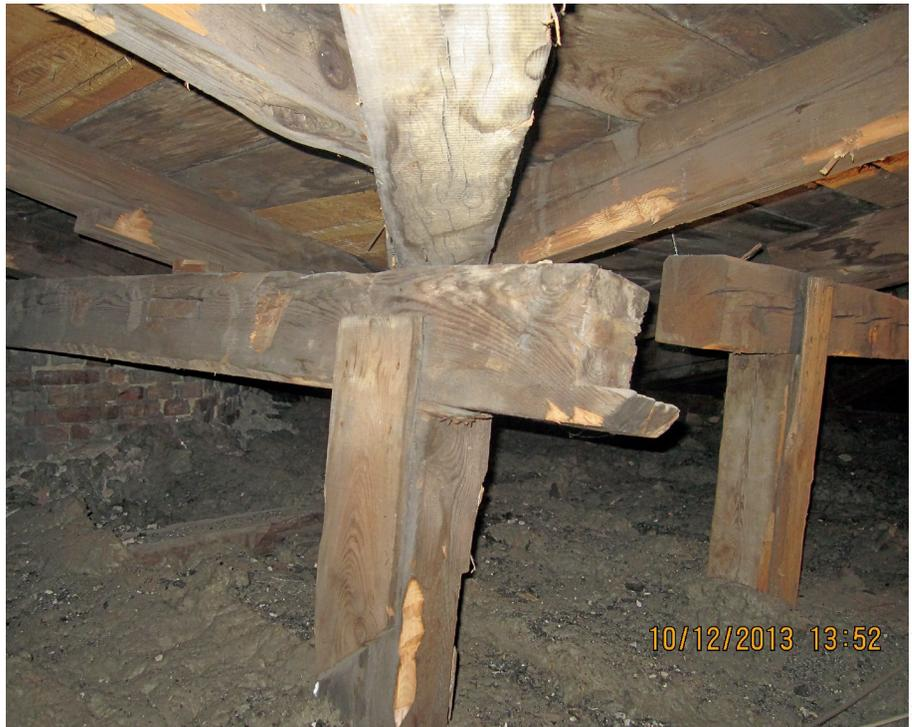
(5) Schiefstellung der hölzernen Kniestöcke im Kehlbereich, fehlender zimmermannsmäßiger Abbund und fehlende Verbindung der beiden Pfettenstränge zur Erzielung ausreichender Längs- und Querstabilität
